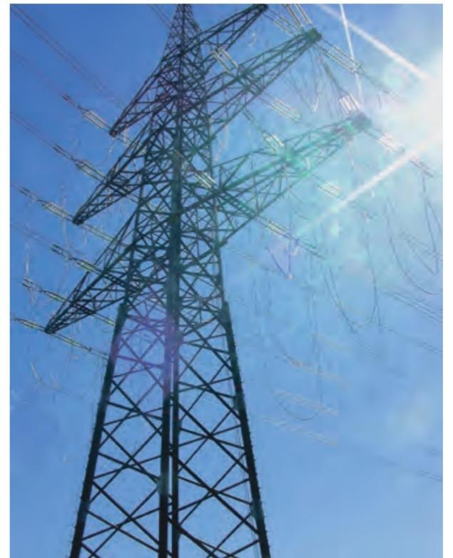
138 Hochspannungsmasten umfasst der neue Versorgungsring im Endausbau. Der höchste Mast ist schon fertig, misst 70 Meter und steht nahe dem Autobahnknoten St. Florian/Asten. Leitungsspannung: 220.000 Volt.
